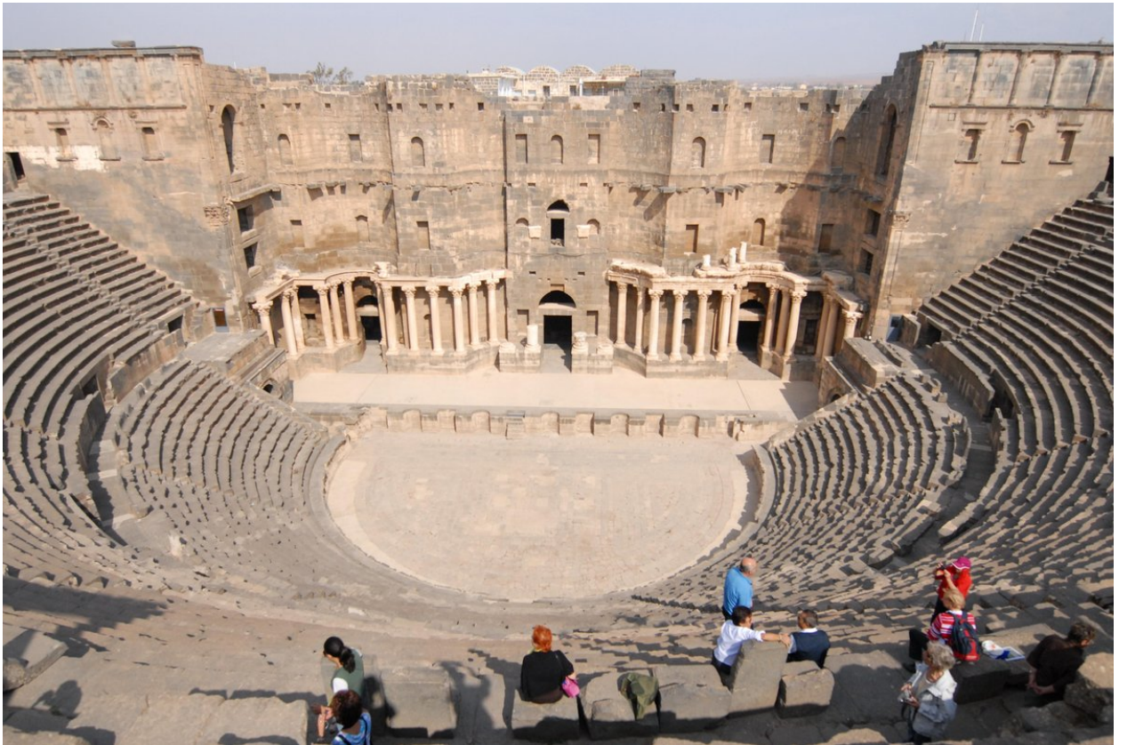
مسرح بصرى وقلعتها جنوب سوريا
