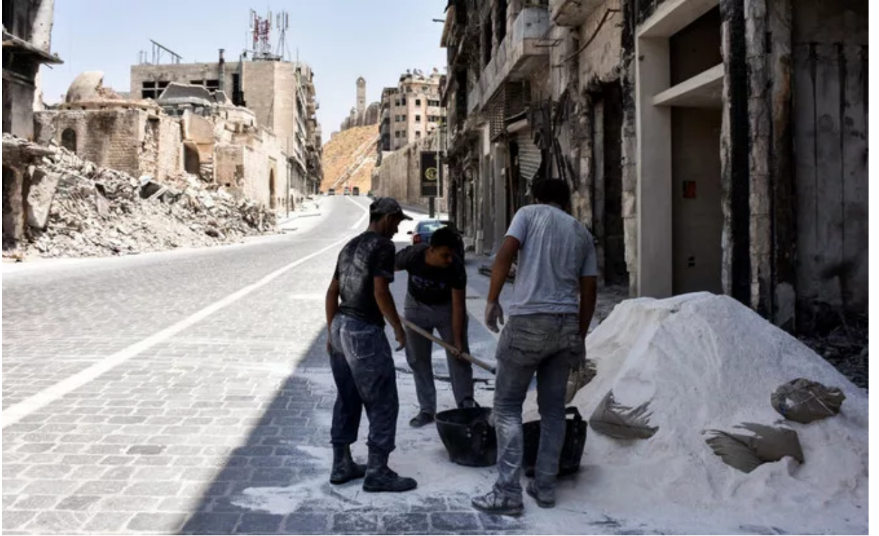
عمليات إعادة إعمار في حلب القديمة أواخر عام 2016.
