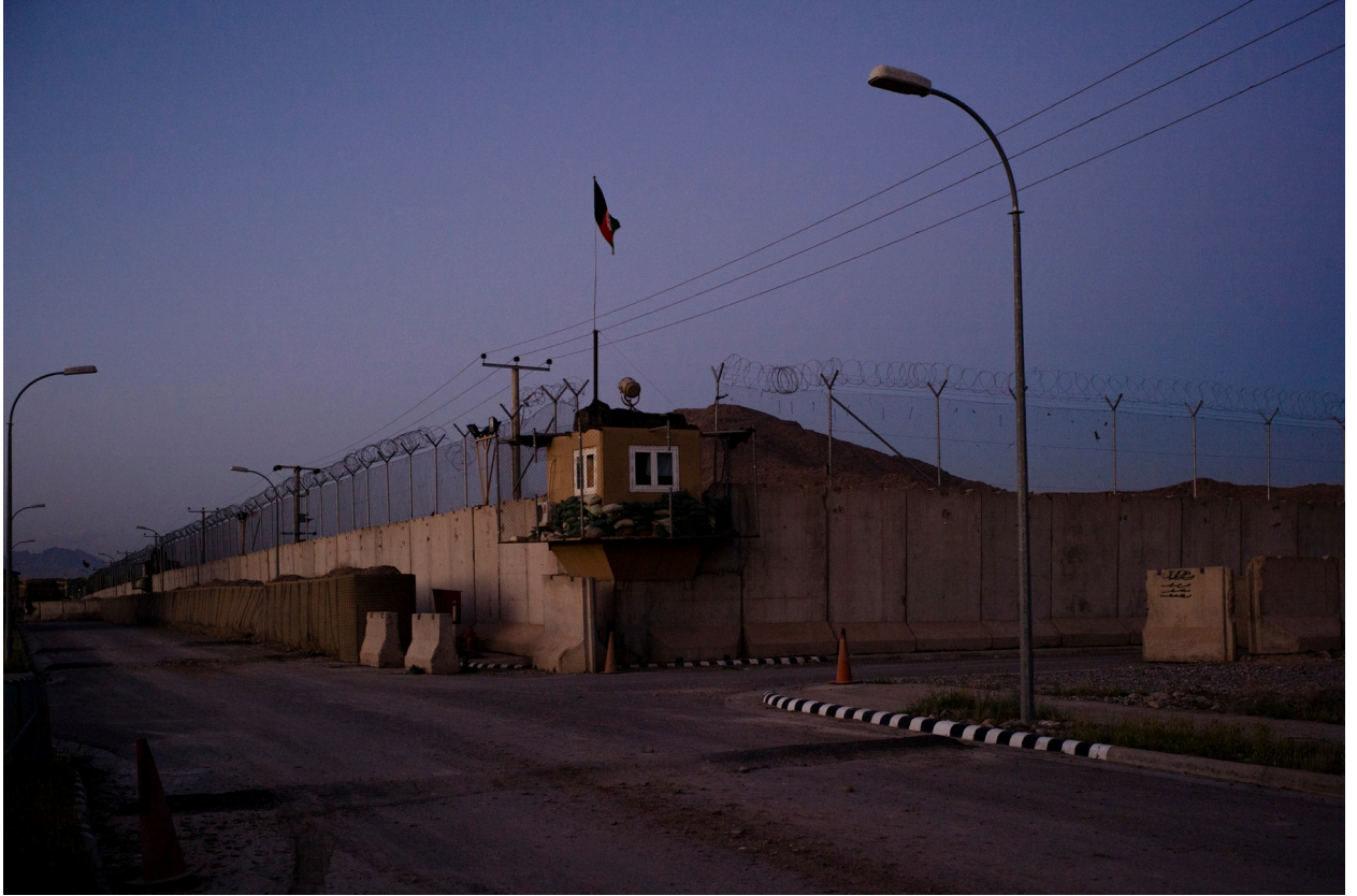
صورة لموقع مولد كهربائي في قندهار في سنة 2015.
